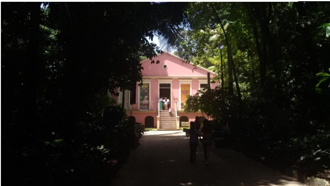
Fotografia 4 - Prédio da Rocinha, hoje Pavilhão Ferreira Penna/MPEG
